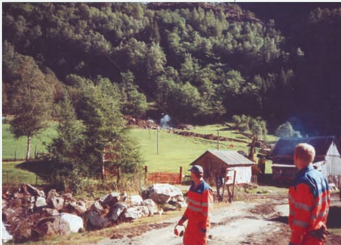
Første dynamittsalva ved nye Sage Kraftverk AS. Foto: Stein Fossen
