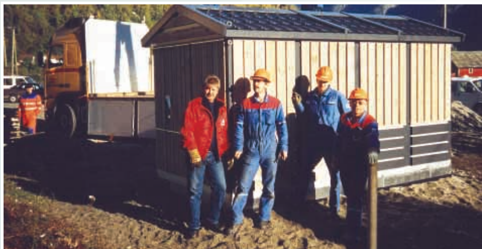
Montasje av ny effektbrytarkiosk Dalsøyri. Foto: Stein Fossen.
